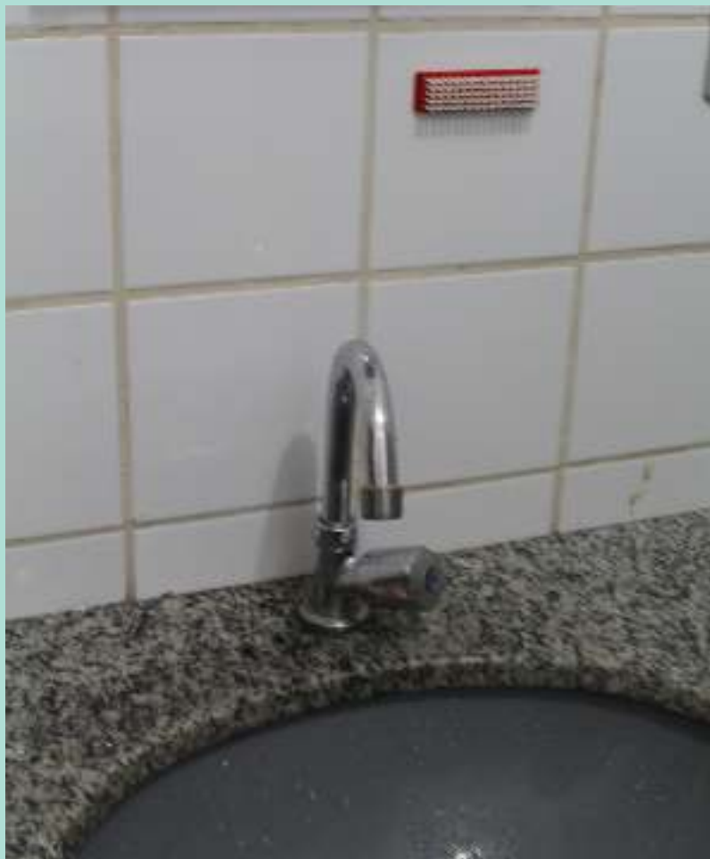
Figura 18: Colagem da escova com fita 3M ® na parede perto da pia.
