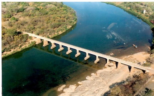
Ponte sobre o Rio das Velhas.
